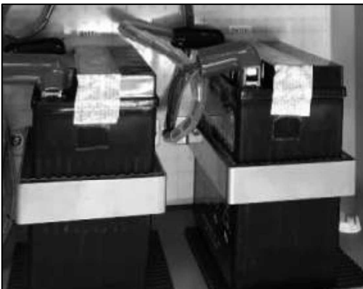
バッテリーとの接続後
